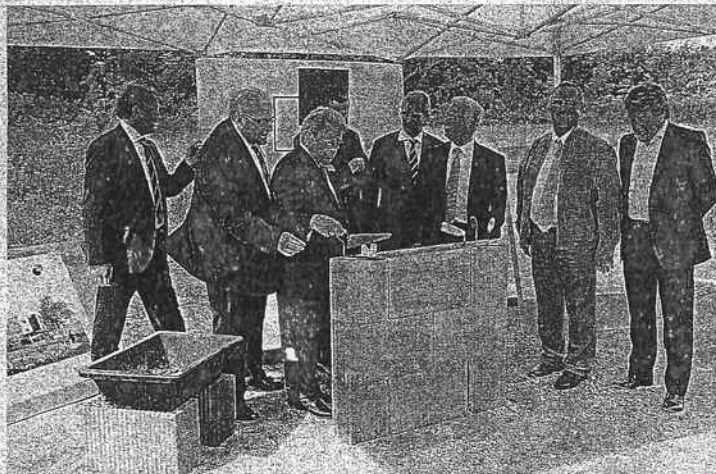
La première pierre de l'EHPAD "Les Fontaines" a été posée, hier, à Kembs. (Photo DNA)
