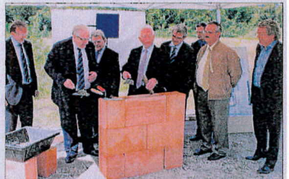
Après la pose de la première pierre, hier, les travaux devraient débuter dans les prochains jours. Photo Detlev Juppé
