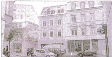
Les trois bâtiments de l'avenue Briand que Batigère a rachetés pour les réhabiliter de fond en comble, un chantier déjà bien avancé. Le bâtiment neuf de 27 logements, lui, se construit derrière.
