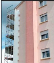
Les bâtiments sont recouverts d'une couche de 20 centimètres de polystyrène.
